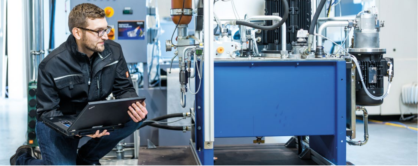
Mobiles Energie-Monitoring in der ETA-Fabrik
